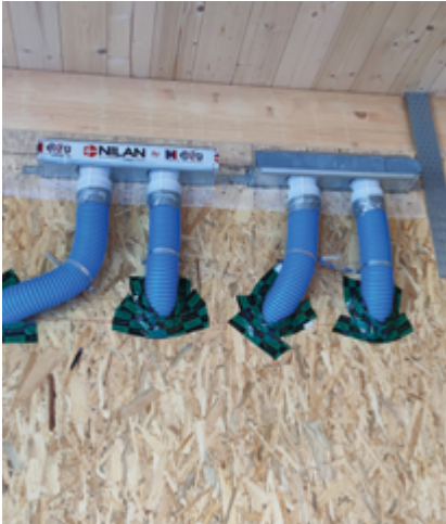
Nastratura "artigianale" di un canale di VMC diretto verso l'esterno dell'involucro.
