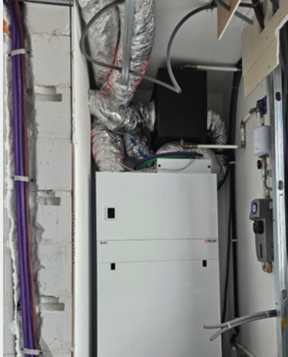
Aggregato compatto con scambiatore geotermico EGWK.
