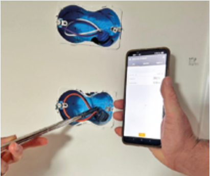
Punti di infiltrazione misurati con la prova del fumo
