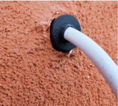
Elementi speciali per la continuità di tenuta all'aria in corrispondenza di attraversamenti impiantistici
