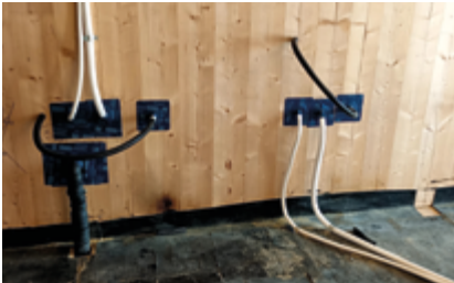
Elementi speciali per la continuità di tenuta all'aria in corrispondenza di attraversamenti impiantistici
