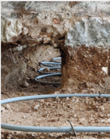
Dettaglio di posa tubazione geotermica con trave di fondazione esistente.
