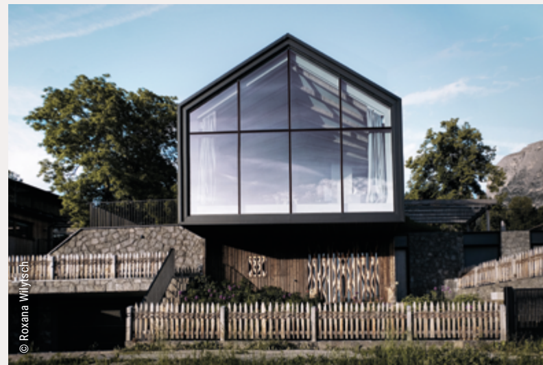
Casa Fiè di Sopra FIÈ ALLO SCILIAR (BZ)
