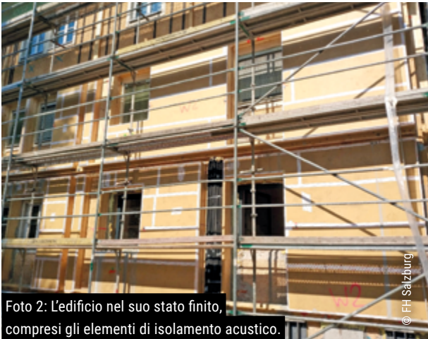
Foto 3: L'edificio dopo il fissaggio degli elementi prefabbricati della facciata. © FH Salzburg
