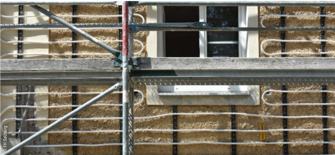
Foto 1: Fissaggio delle tubazioni alla muratura esistente. In generale è preferibile la posa orizzontale delle tubazioni rispetto a quella verticale, per evitare che si creino sacche d'aria nella tubazione stessa con conseguenti malfunzionamenti in fase di esercizio.
