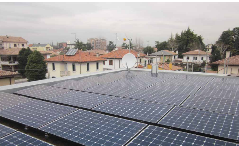
Pannelli fotovoltaici posizionati sulla copertura del nuovo ampliamento
