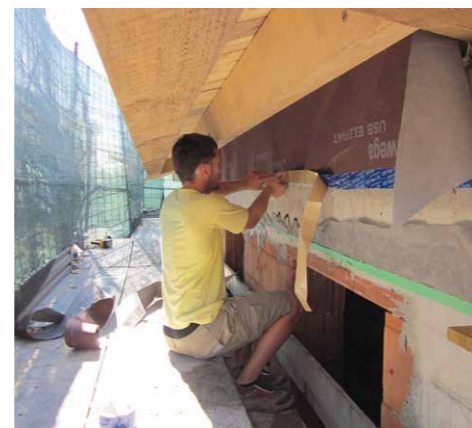
Isolamento e sigillatura all'aria del tetto preesistente
