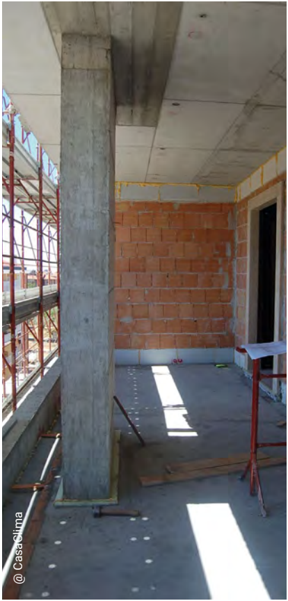
Foto 3 - Soluzione del ponte termico tra parete e terrazze
