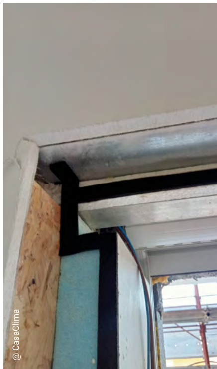
Foto 5 - Posa del nastro BG1 sul controtelaio, per la tenuta all'aria dell'infisso
