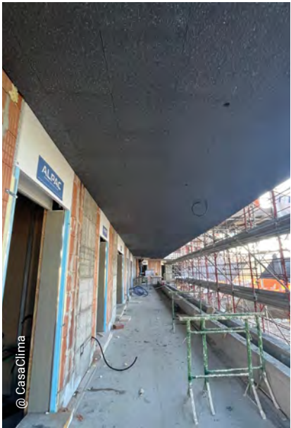
Foto 2 - Posa isolante per correzione ponte termico parete terrazze
