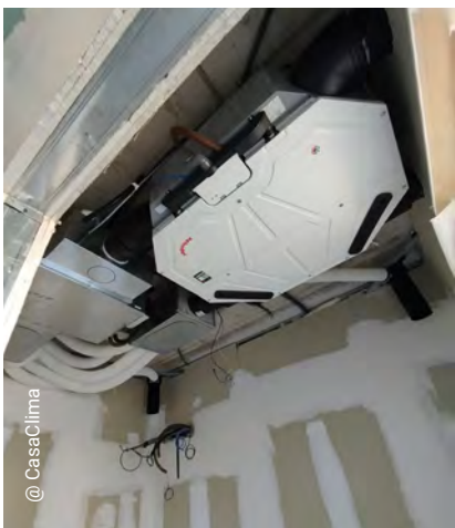
Foto 8 - Macchina VMC centralizzata in ogni singolo appartamento
