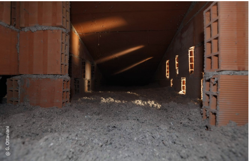
Fiocchi di cellulosa posati nell'estradosso del solaio
