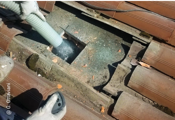
Insufflaggio del sottotetto mediante foro in copertura
