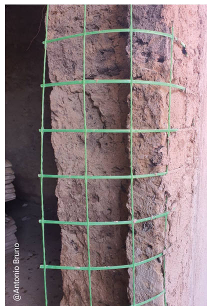
Figura 3 - Intonaco termico a spessore
