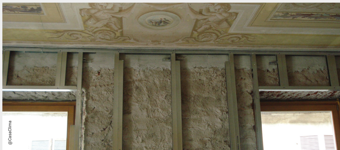
Foto 6 - Ristrutturazione con isolamento dall'interno delle pareti
