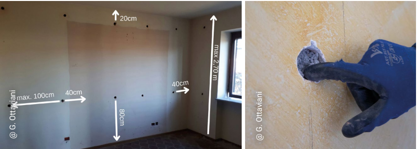
Distribuzione dei fori, riempimento dell'intercapedine con bocchettone girevole, controllo visivo della corretta compattazione dei fiocchi di cellulosa.
