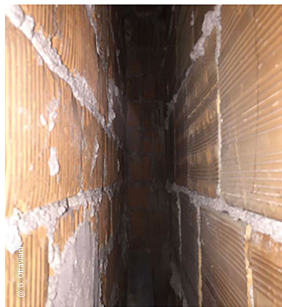
Esempio di verifica della stratigrafia dell'intercapedine attraverso una telecamera endoscopica.
