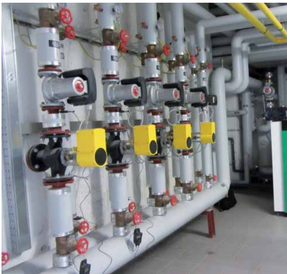
Misurazione dei circuiti di mandata del riscaldamento
