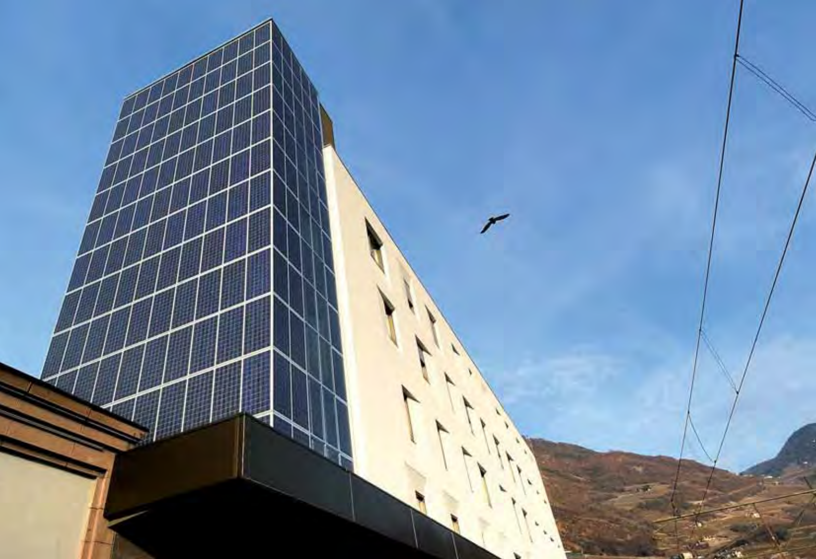
Palazzo provinciale "Ex-Poste", Bolzano - CasaClima Gold - Arch. M. Tribus
