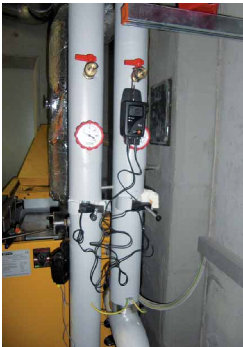
Applicazione dei sensori alle tubazioni del riscaldamento
