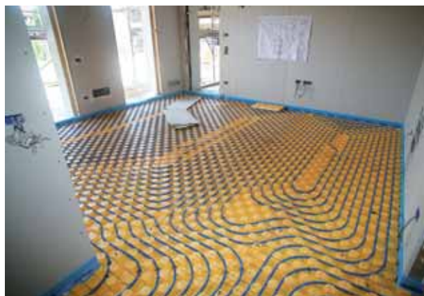
Sistema radiante a pavimento
