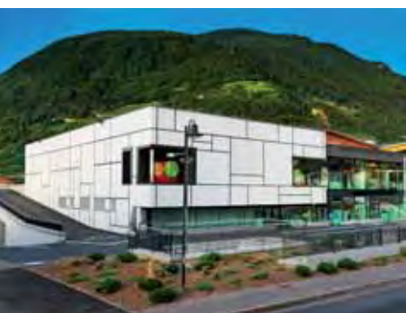
Centro commerciale realizzato con PROGRESS Thermowand®
