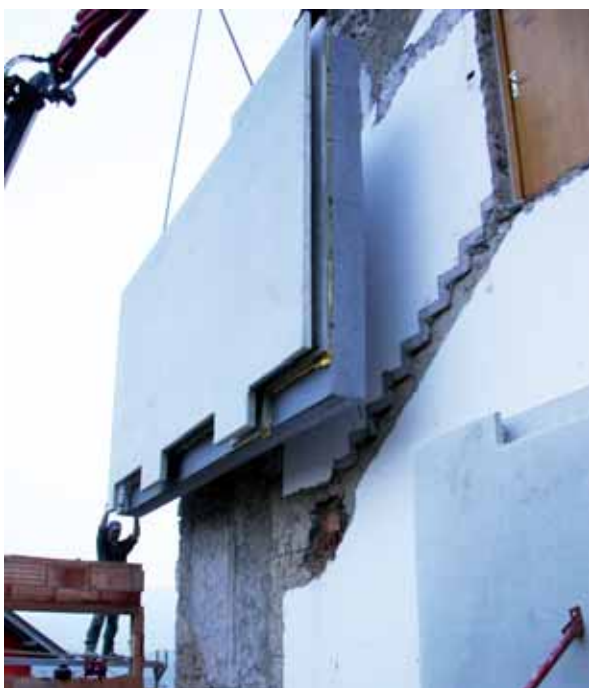
Alcune fasi della messa in opera delle pareti prefabbricate in c.a.
