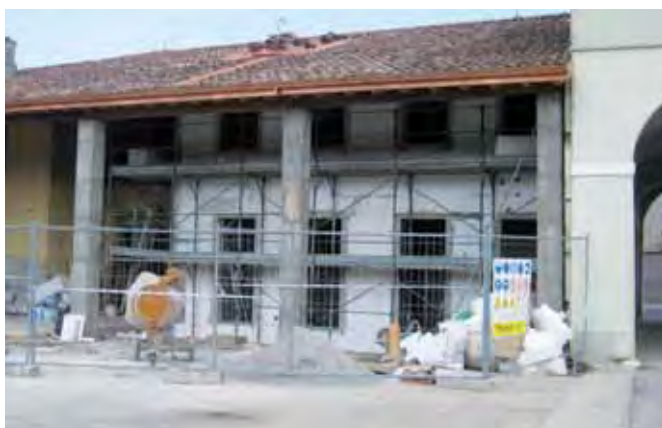
Posa del cappotto termoisolante lato sud
