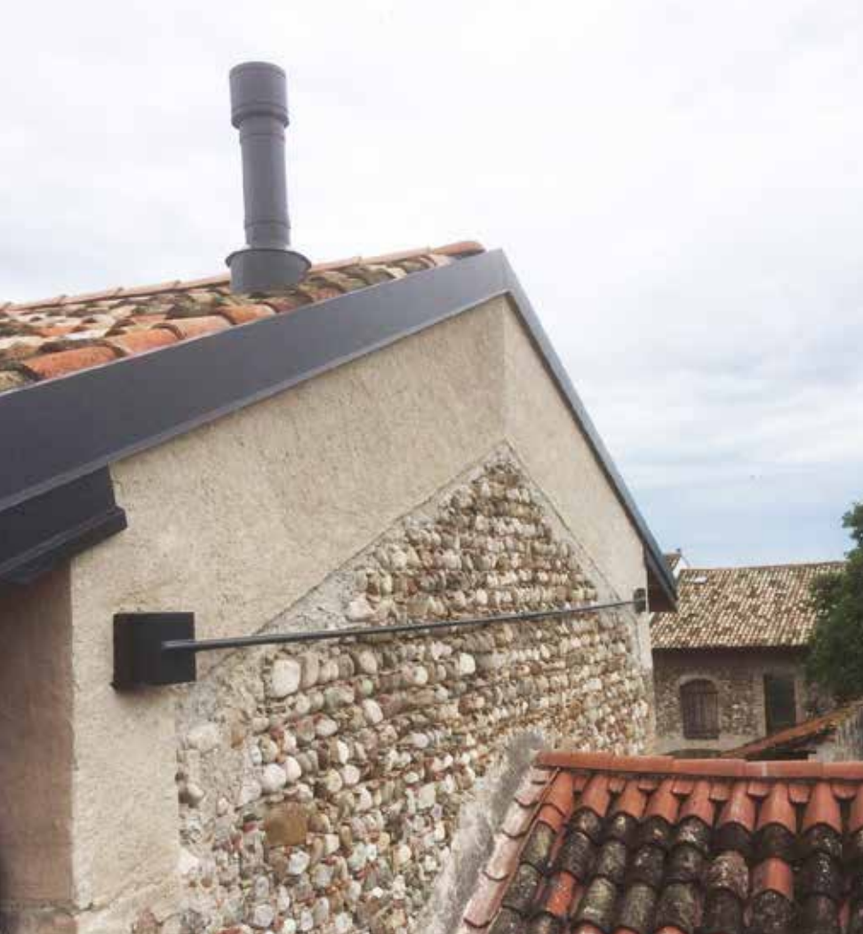
Fronte Ovest PostOperam - Dettaglio dei nuovi tiranti strutturali
