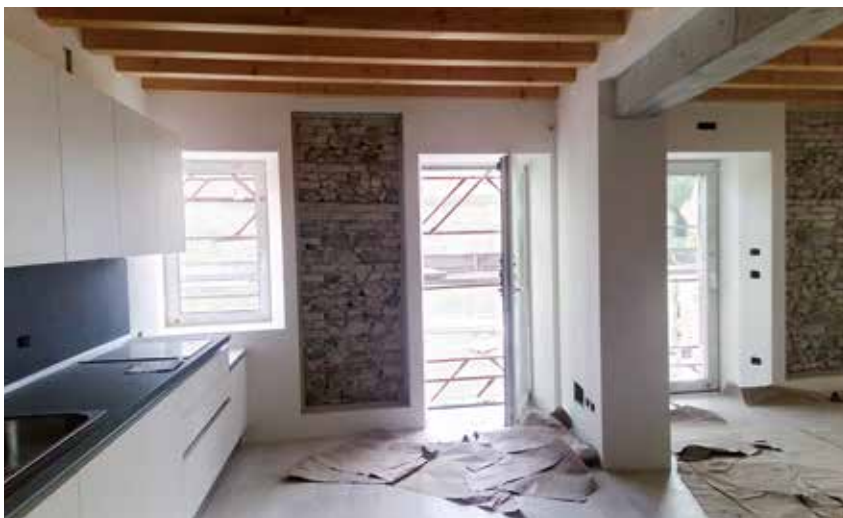
Vista interna della zona giorno - valorizzazione della struttura originaria in sasso
