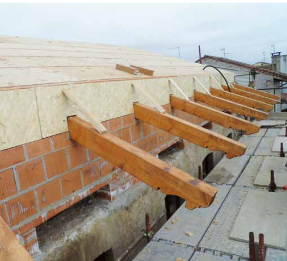
Copertura in fase di realizzazione
