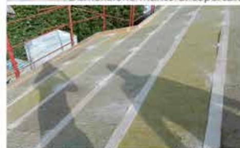
Coibentazione copertura con fibra di legno
