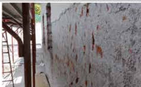
Demolizione intonaco
