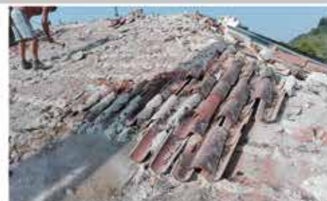
Demolizione manto di copertura
