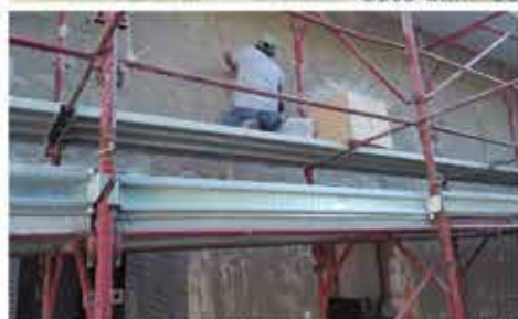
Applicazione intonaco armato Kerakoll
