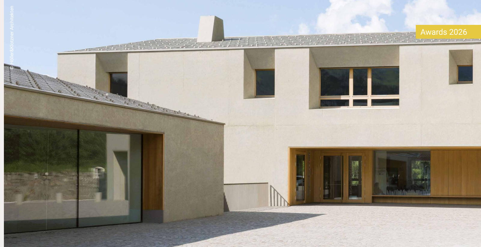
Grundschule Riffian | Scuola elementare Rifiano Riffian (BZ) / Rifiano (BZ)
