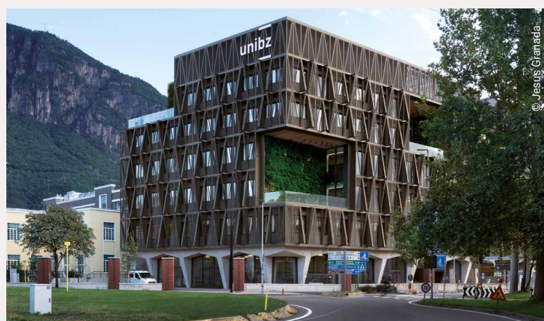
NOI Techpark - Gebäude B1 (Ingenieursfakultät der Unibz) | NOI Techpark - Edificio B1 (Facoltà di Ingegneria di Unibz) Bozen (BZ) / Bolzano (BZ)
