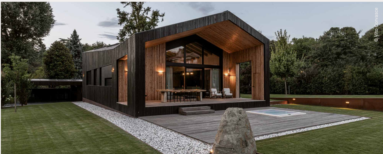
Casa Sanai Ariccia (RM)
