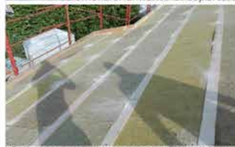
Coibentazione copertura con fibra di legno
