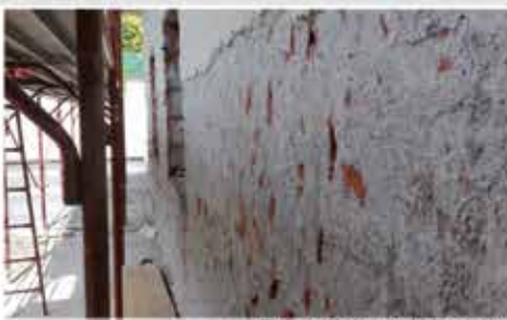
Demolizione intonaco
