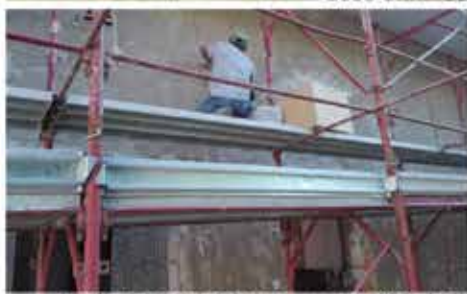
Applicazione intonaco armato Kerakoll
