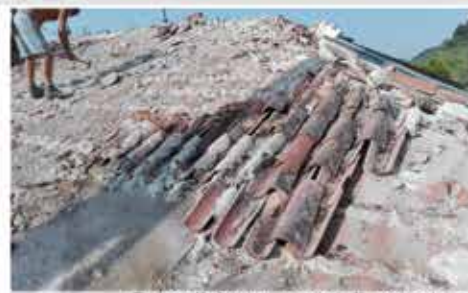
Demolizione manto di copertura
