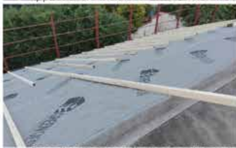
Posa listelli di ventilazione sottotegola
