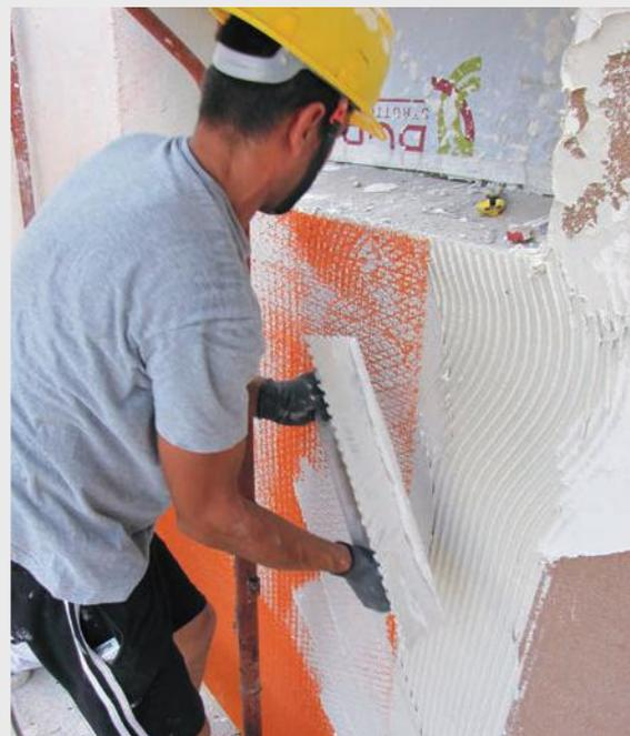
Applicazione della rete quadriassiale in fibra di vetro con intonaco di calce per il rinforzo dei tamponamenti esterni
