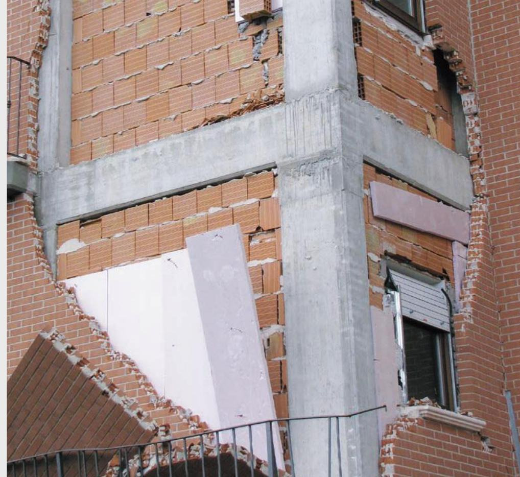
Doppia parete di tamponamento con interposto isolante in cui la mancanza di collegamenti ha portato al crollo del paramento esterno
