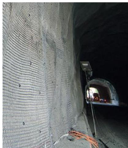
sa sui sistemi RÖFIX SismaCalce®, ARMOSystem e sulle linee RÖFIX Belit Solido e Creteo®Special: soluzioni basate sull'impiego di malte minerali abbinate a reti di armatura in fibre speciali, appositamente sviluppate per rispondere alle esigenze di rinforzo e adeguamento sismico delle diverse strutture esistenti in **muratura portante**, di **tamponamento** o in **calcestruzzo armato**.
