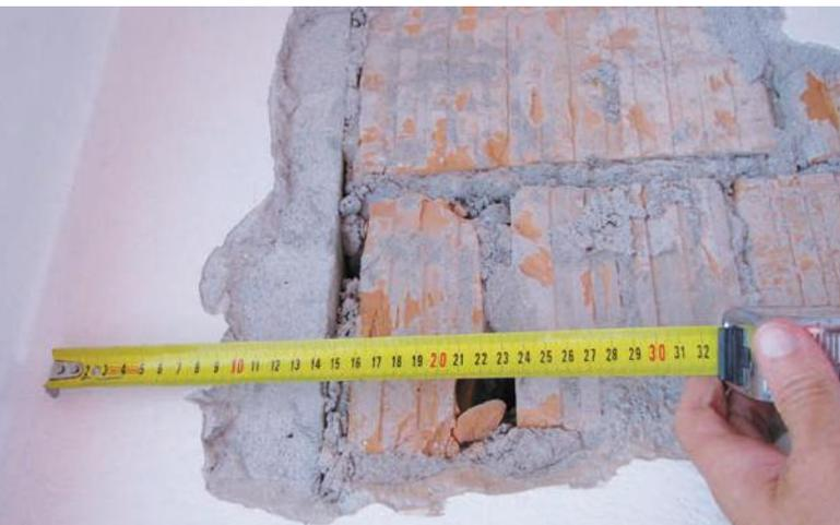
I sondaggi puntuali in fase di rilievo consentono di individuare la posizione di pilastri e murature "nascosti" sotto l'intonaco, evitando quindi errori importanti nella valutazione strutturale e termica.
