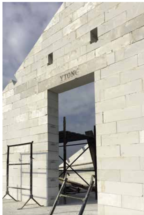
Muratura portante con gli incastri per l'appoggio delle travi del tetto.
