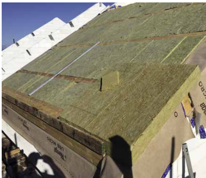
Prima parte del pacchetto di coibentazione in fibra di roccia della copertura.
