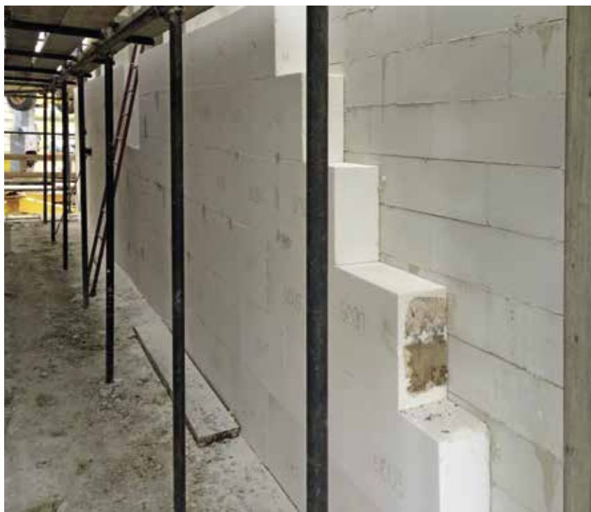
Cappotto in blocchi di silicato di calcio spessore 22 cm.
