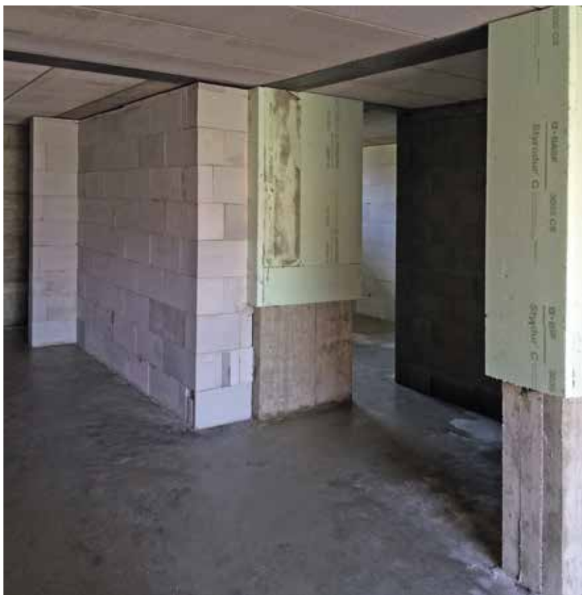
Cappotto dei pilastri passanti dal piano interrato al piano terra.
