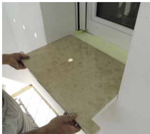
Installazione della soglia esterna; si scorge l'XPS sottosoglia utile ad evitare il ponte termico.
