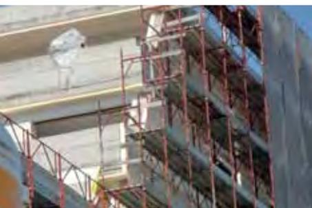
I pannelli di spessore 50 mm applicati al soffitto delle logge
