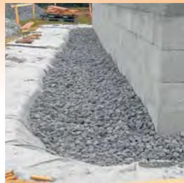
ISOLAMENTO TERMICO • BARRIERA CAPILLARE • DRENAGGIO • RESISTENZA AI CARICHI
