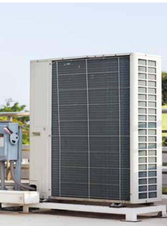
Esempi di sistemi impiantistici in copertura: è necessario un vincolo rigido o flessibile
