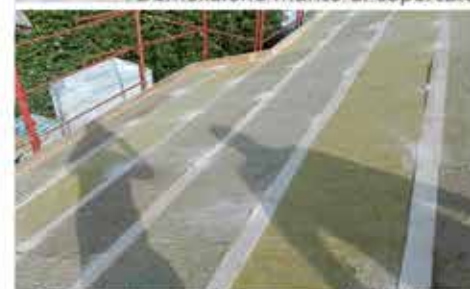
Coibentazione copertura con fibra di legno
