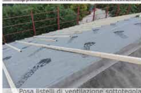
Posa listelli di ventilazione sottotegola
