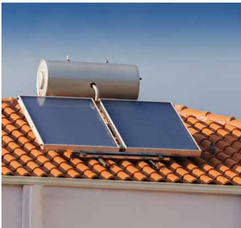
Esempi di sistemi impiantistici in copertura: è necessario un vincolo rigido o flessibile
