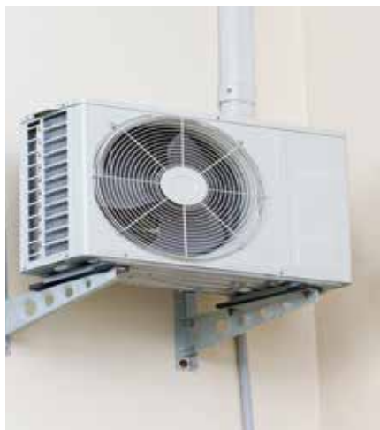
Esempi di sistemi impiantistici appesi all'esterno (in facciata) e all'interno di un vano tecnico
