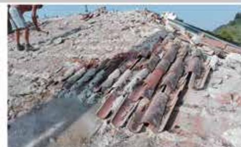
Demolizione manto di copertura
