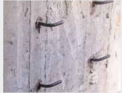
Dettaglio dei connettori ancorati con resina epossidica al pilastro esistente
