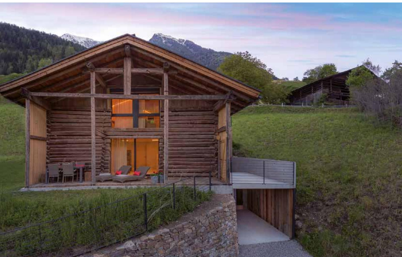
La storia di questo progetto inizia nel 2011 quando l'originale struttura in legno, molto ben conservata, con elementi strutturali che risalgono al XIV secolo, fu attentamente smontata e tutti i pezzi furono numerati e immagazzinati. Successivamente, nel 2012, furono acquistati da un'abitante di San Mar-
