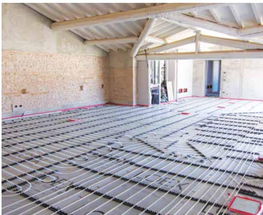
Figura 5. Sistema radiante a pavimento nell'azienda Acquaviva Italia. Particolare dell'ancoraggio delle tubazioni (Fonte: LOEX)
