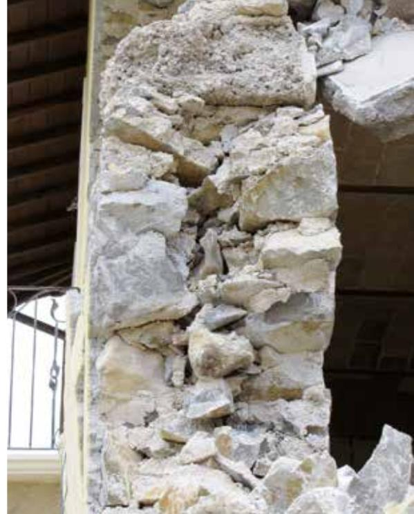
Foto 3: Muratura in pietra irregolare e con malta di qualità scadente
