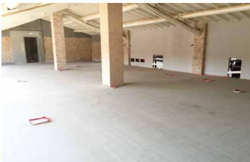
Figura 6. Posa del massetto fluido (Fonte: LOEX)
