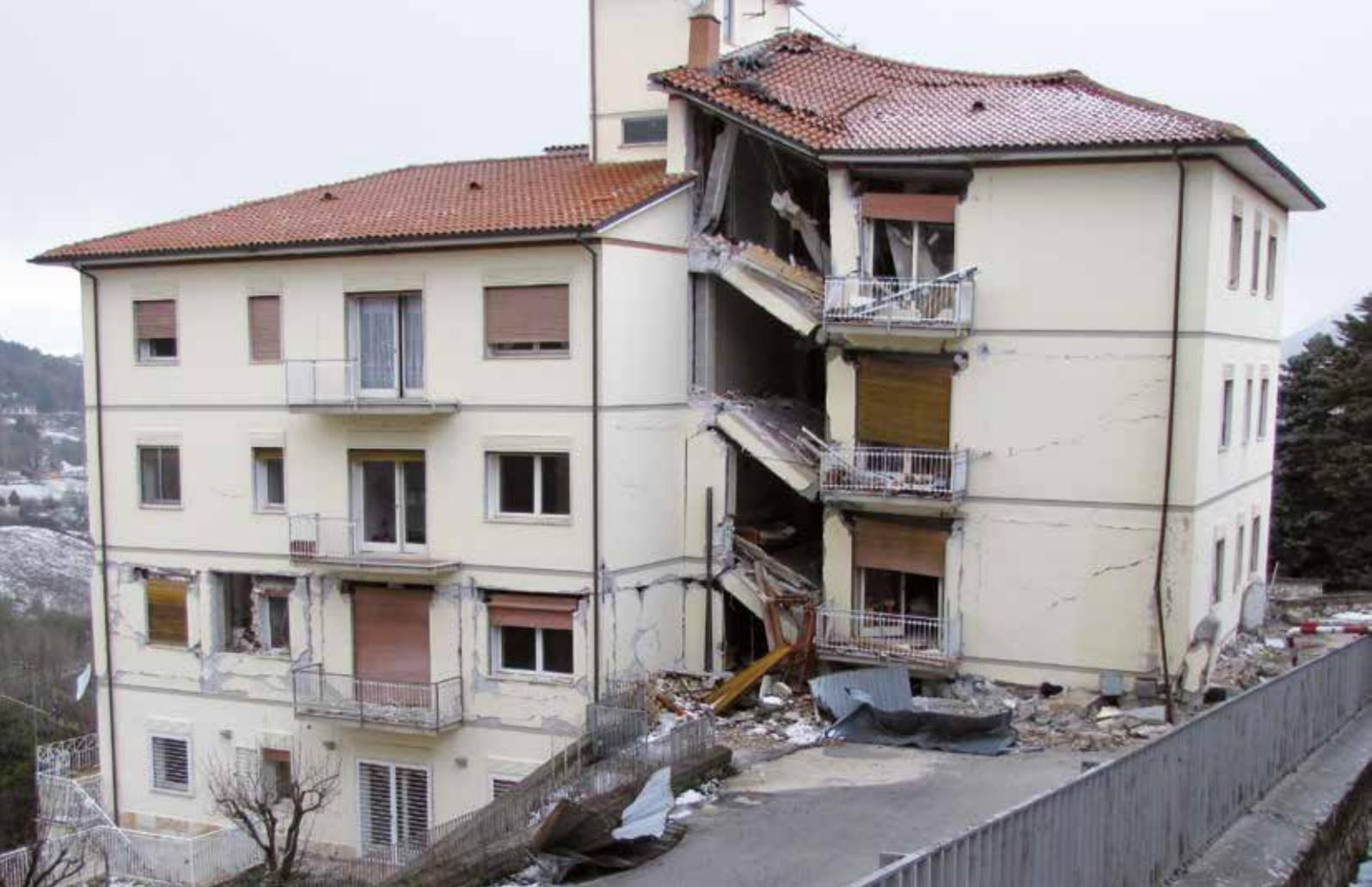
Foto 4: Edificio irregolare in pianta ed elevazione con crollo totale del piano terra a livello strada.
