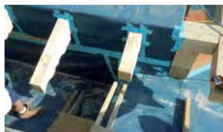
FOTO 7 – La foto mostra la nastratura dei finti travetti lungo tutto il perimetro per il raccordo con il telo di tenuta al vento e impermeabilizzazione.
