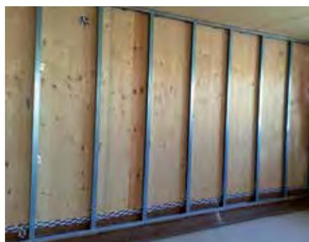
FOTO 2 – Attacco a terra di un edificio con struttura in Xlam. In questo caso la tenuta all'aria del nodo è stata garantita tramite un telo nastrato alla parete e alla platea. La foto mostra il telo nastrato alla parete prima del fissaggio alla platea e prima della posa del massetto alleggerito.
