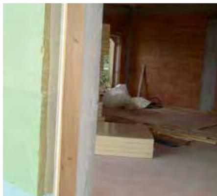
FOTO 1 – Attacco a terra di un edificio in muratura. La foto mostra una muratura di tamponamento prima del getto del massetto. In questo caso la tenuta all'aria viene garantita dall'intonaco interno.
