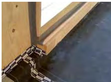
FOTO 4 - Attacco tra un solaio di interpiano e una parete in Xlam: per garantire la tenuta all'aria del nodo, il telo, posto all'estradosso del solaio per proteggere e separare l'Xlam dal massetto alleggerito, è stato opportunamente nastrato alla parete e al controtelaio dell'infisso.
