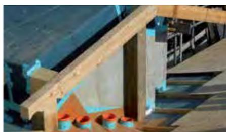
Foto 6 – La foto mostra dei pezzi speciali utilizzati per gli elementi passanti e le relative nastrature per il raccordo con il telo di tenuta al vento e impermeabilizzazione.
