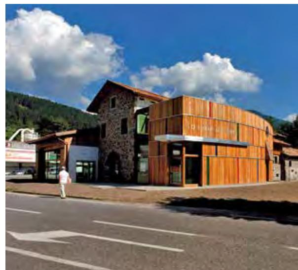
Le superfici e le membrature strutturali sono state restaurate in modo da recuperare la tessitura originaria, o in alternativa ricostruite con altre nuove, analoghe per materiale, funzione e forma.
