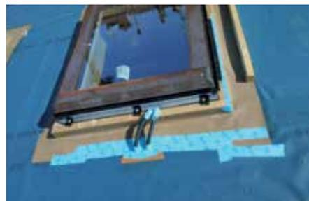
FOTO 9 – Nastratura del corrugato per la motorizzazione del lucernario passante il pacchetto di copertura.
