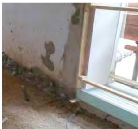
FOTO 3 – Ripristino del supporto ammalorato in corrispondenza dello spessore del massetto in un nodo tra parete e solaio di interpiano
