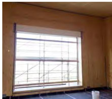
FOTO 5 - Attacco tra un solaio di interpiano e una parete in Xlam: per garantire la tenuta è stata posata una nastratura di raccordo alla parete anche all'intradosso del solaio.
