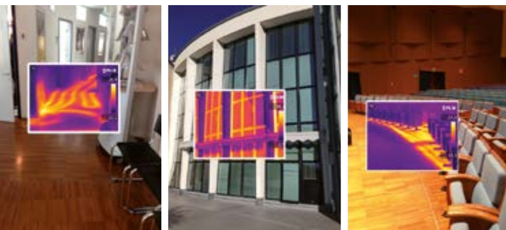
Figura 4. Termografie interni ed esterni degli uffici e della sala del Teatro
