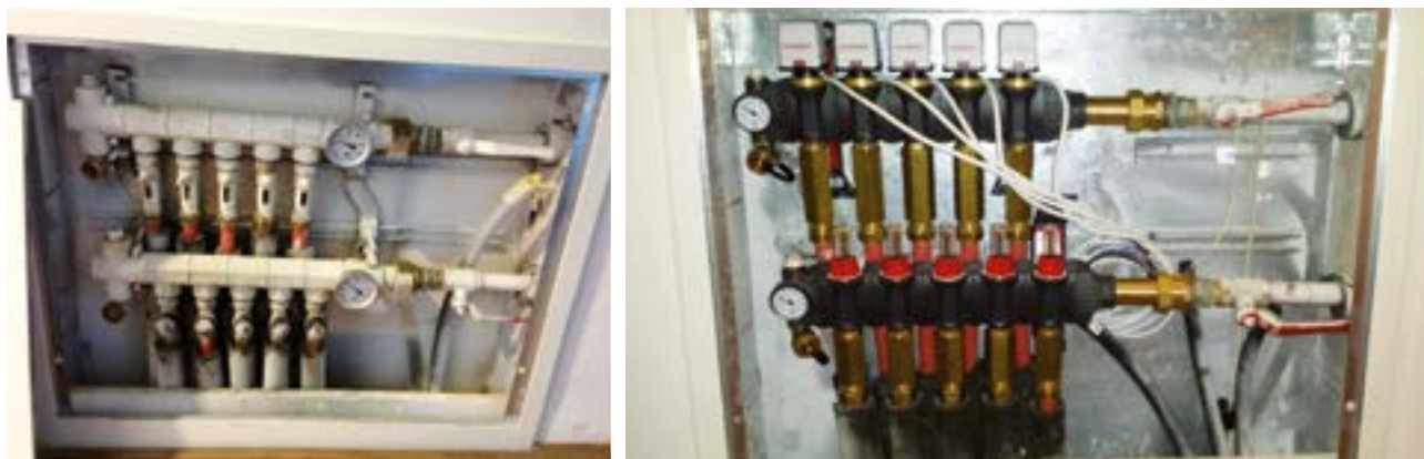
Figura 9. Riqualificazione dei collettori del sistema radiante (a sinistra prima dell'intervento, a destra dopo l'intervento).
